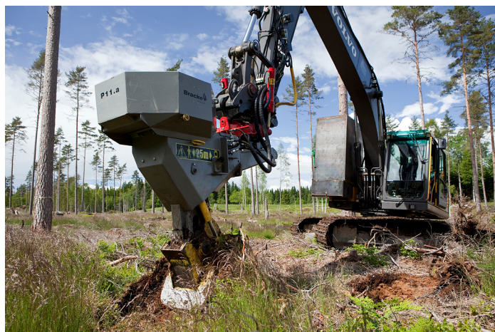
Mit Modell P11.a wird eine Bodenaufbereitung und Pflanzung durchgeführt.
